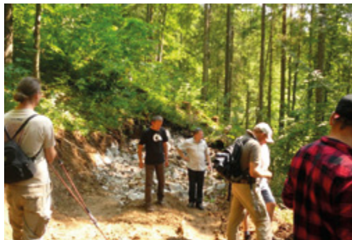
Wegebau in Langau (Foto: J. Rosemund)
