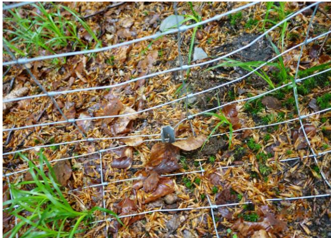
Die Absicherung des Knotengeflechts mittels eines Bodenankers. Foto: Stefan Schneider
