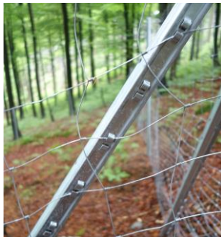
Das Knotengeflecht sollte wo immer möglich in den Pfählen eingehängt werden. Foto: Stefan Schneider
