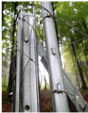
Der obere Eingangsbereich samt Absicherung zum Einhängen. Foto: Stefan Schneider
